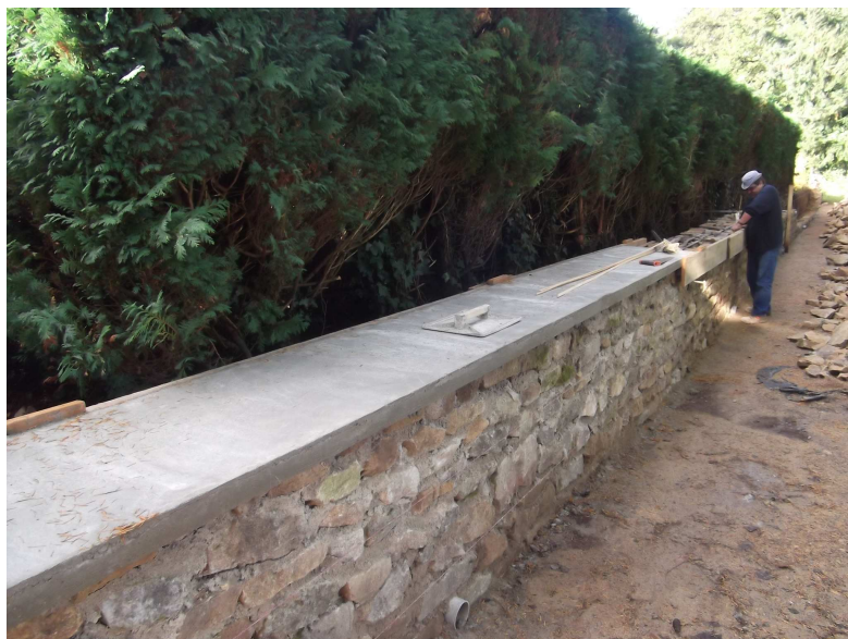
Réfection du mur du cimetière
