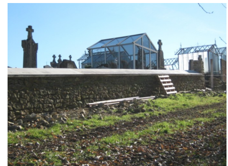
Réfection du mur du cimetière
