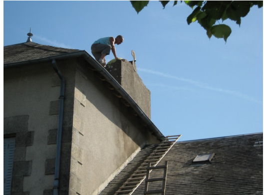
démontage des cheminées 1435 € Remplacement des gouttières 4400 €
