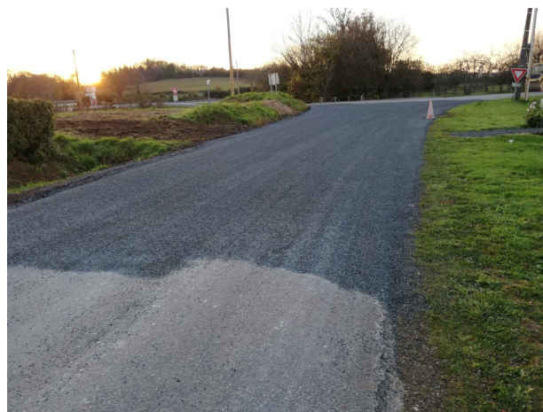
réfection de chaussée aux Fougères
